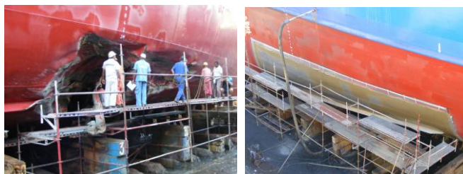
Photos : la partie déchirée par le rocher avant et après réparation.
